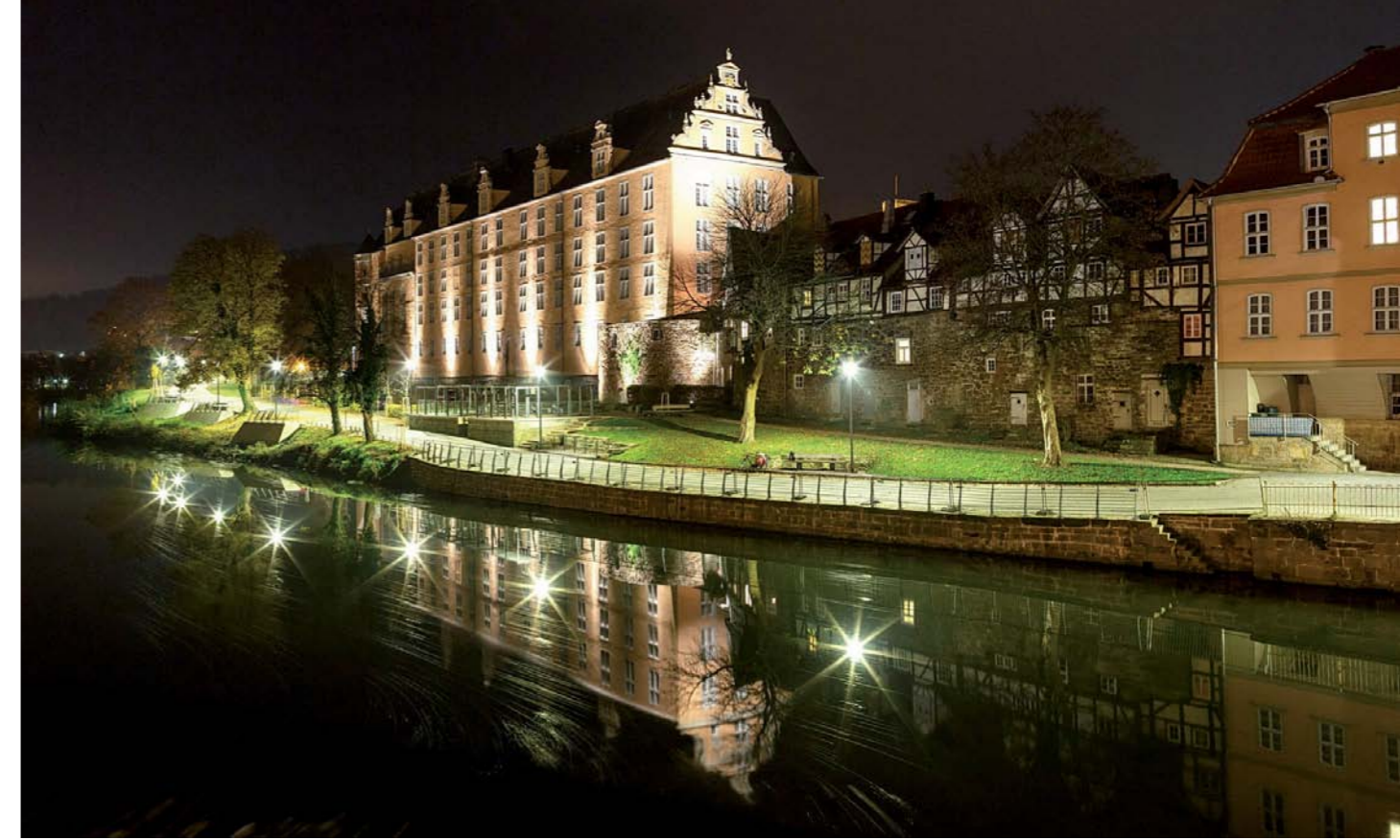
Umgestaltung, Erlebarmachung und Inszenierung des Dielengrabens
